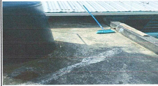
Foto 2: limpieza de la terraza para realizar el trabajo de impermeabilizacion para evitar filtracion de agua de lluvia a las paredes.
