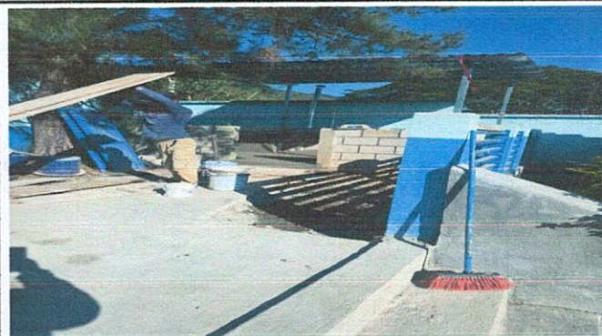
Foto 4: levantado de cocina tipo portico con techo
