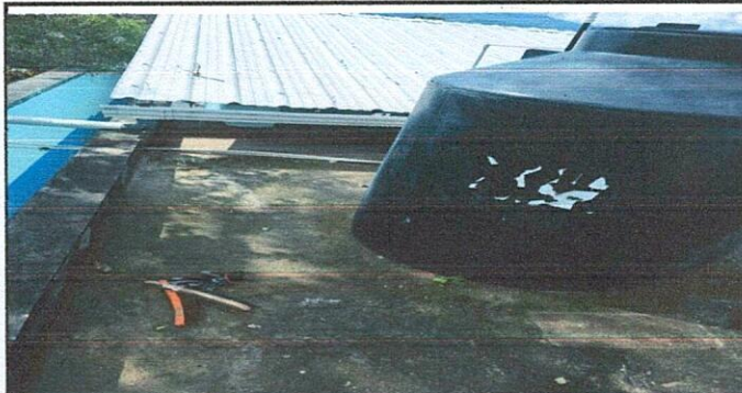
Foto 5: levantamiento de tinaco para cambio y coneccion de agua
